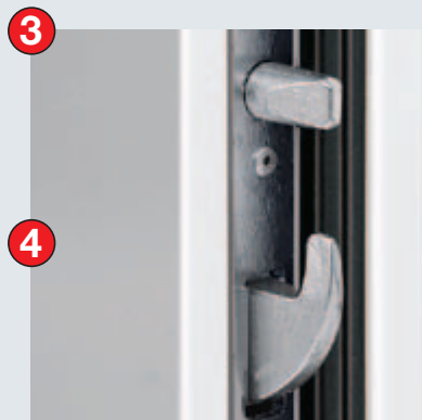
Schwenkriegel mit Sicherungsbolzen
